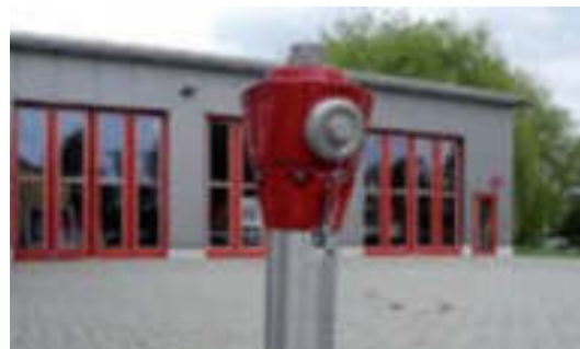
Abbildung 25: Oberflurhydrant
