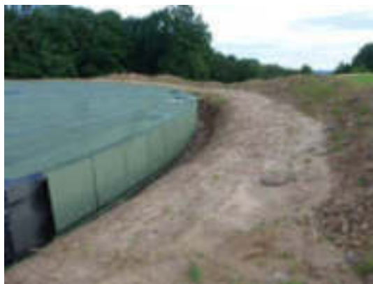
Abbildung 47: Neue Außenbeschichtung
