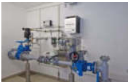
Abbildung 8: Hydraulik einer Brunnenanlage
