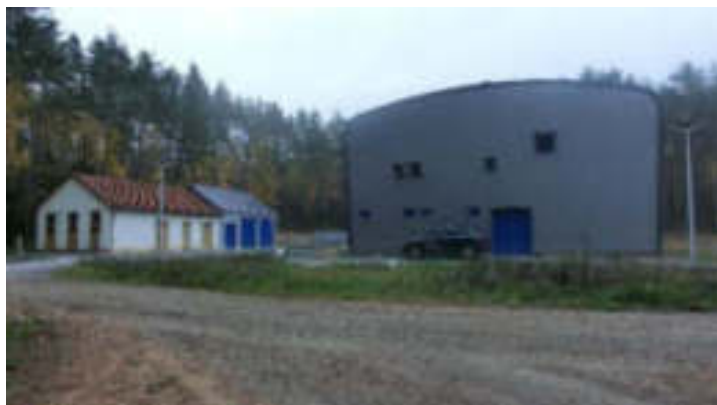
Abbildung 38: Neues Wasserwerk in Betrieb
