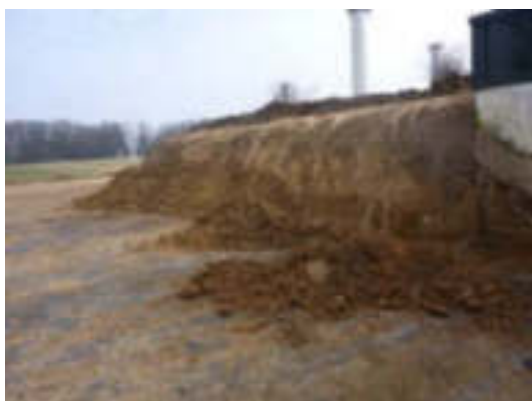
Abbildung 46: Räumung des Behälters
