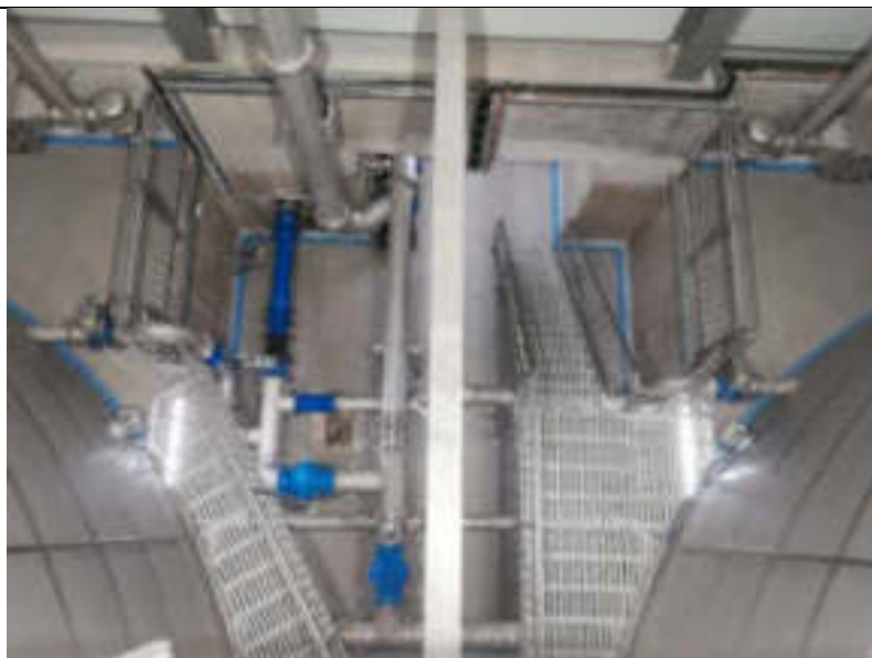
Abbildung 42: Edelstahlrundbehälter 2 x 1.000.000 l Wasserinhalt
