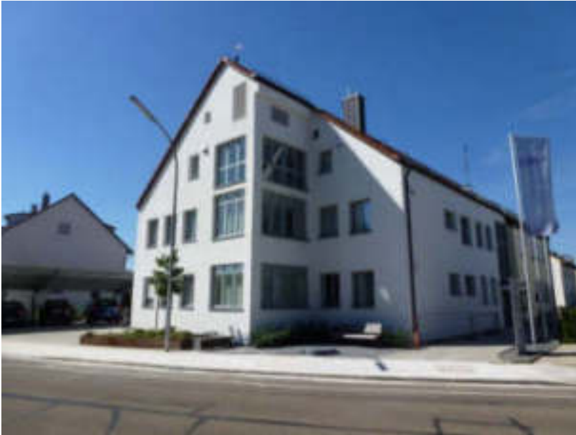
Abbildung 27: Verwaltungsgebäude in Gunzenhausen
